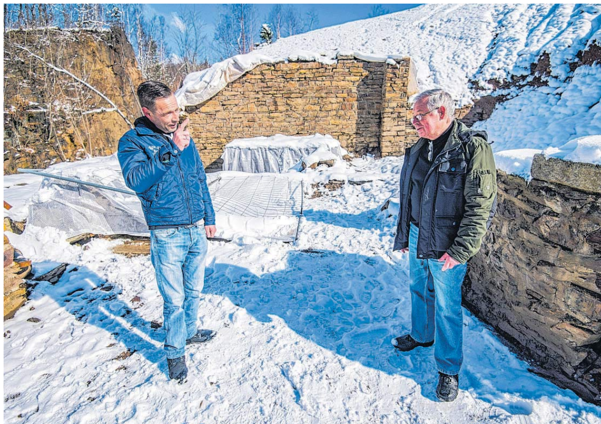
Was vom Freibad bleibt: Kai Ebert (l.) und Rudolf Hunger vor den freigelegten Mauerresten. Ungefähr so soll es auch künftig aussehen, nur aufgeräumter. Hunger ist der Entdecker der Nixenzehen. FOTO: GEORG DOSTMANN
